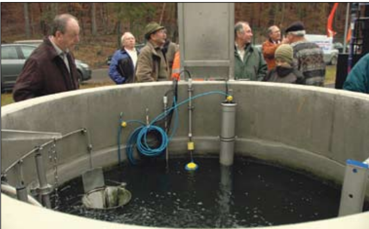
Mitten im Wald liegt die neue Gruppenkläranlage bei Ruppertsweiler, die die Tage ihren Betrieb aufnahm. Gute Nachrichten für Münchweiler, Rodalben und die Orte im Schwarzbachtal. Denn das gereinigte Wasser fließt wie bisher in die Rodalb, die nun noch sauberer werden dürfte. Text und Foto: dr
