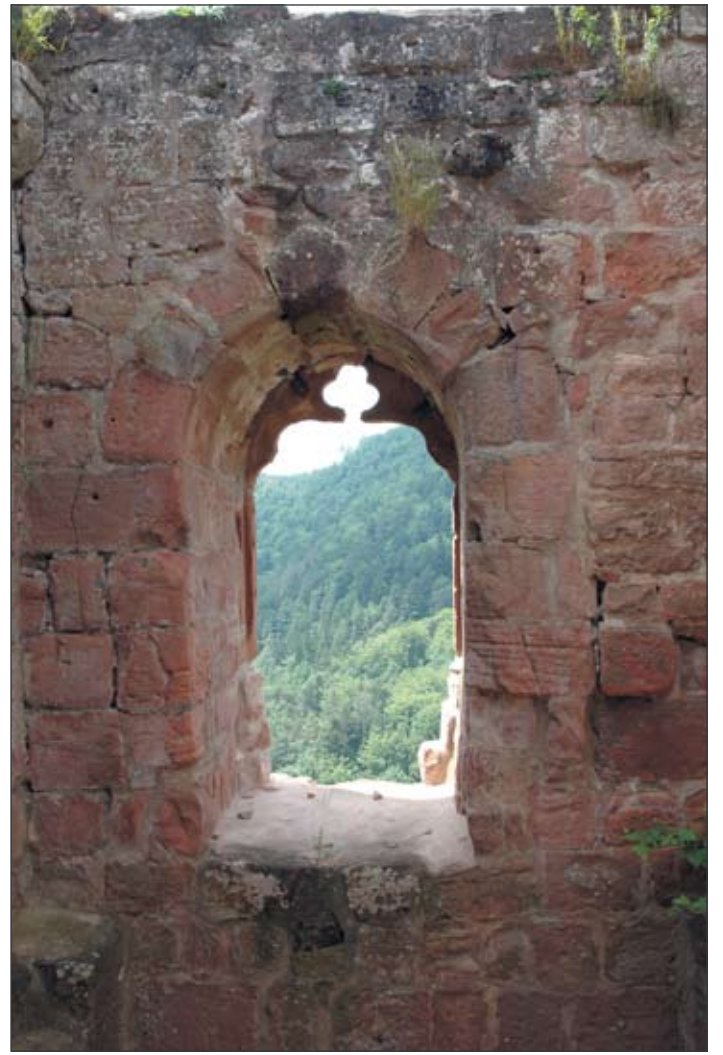
Nur noch Fragmente sind von den gotischen Fenstern im Wohnturm des Wasigensteins erhalten..
