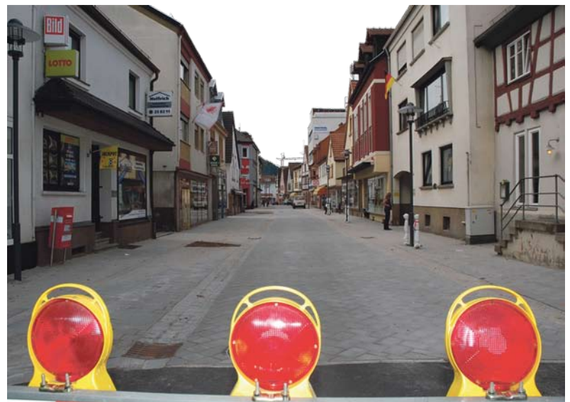
Noch nicht für den Verkehr freigegeben: Der vorerst letzte Bauabschnitt in der Rodalber Hauptstraße
