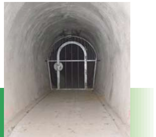
Bestehender Fluchtstollen zum Stauffertunnel
