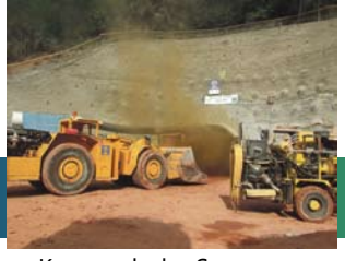
Kurz nach der Sprengung
