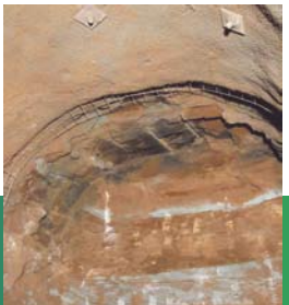
Ortsbrust nach der Sprengung
