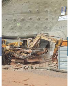
Sprengung, Schallschutz am Portal
