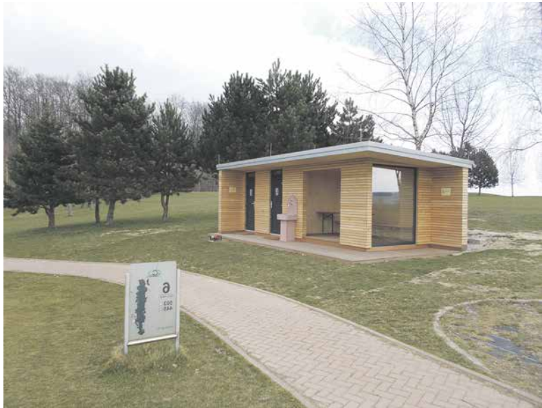
Das neue Blitzschutzhaus mit einem modernen Toilettenhaus fügt sich harmonisch in das Golfplatzgelände ein.
