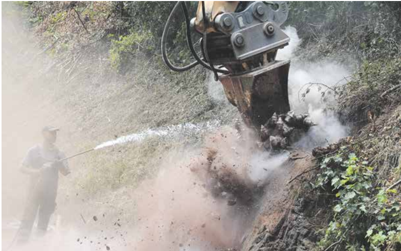
Spezialfräsen nagen sich in den Hang. An heißen Tagen muss wegen Funkenflug gekühlt werden.
