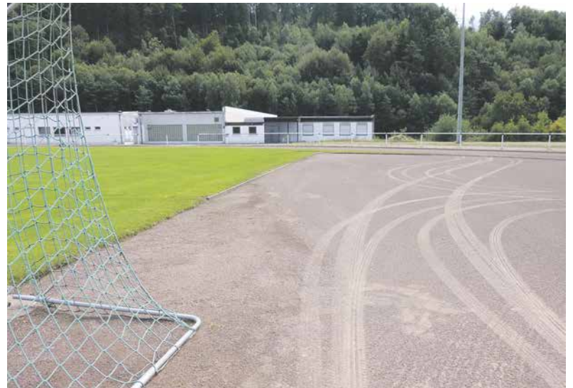
Alle Abgrenzungen mit Rechen von Hand ausgeglichen
