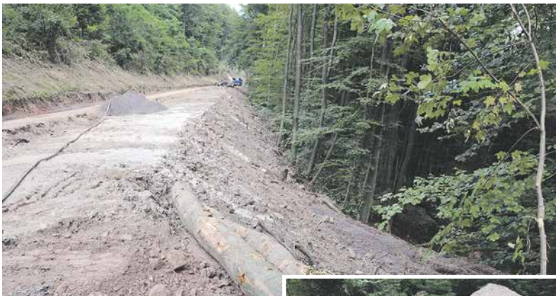
Das alte Guss-Wasserrohr der Stadtwerke Pirmasens lag 100 Jahre unter der Straße. Das neue verläuft im Tal. "Betonfelsbalken", der die Straße hunderte von Metern lang an der Hangseite tragen wird.
