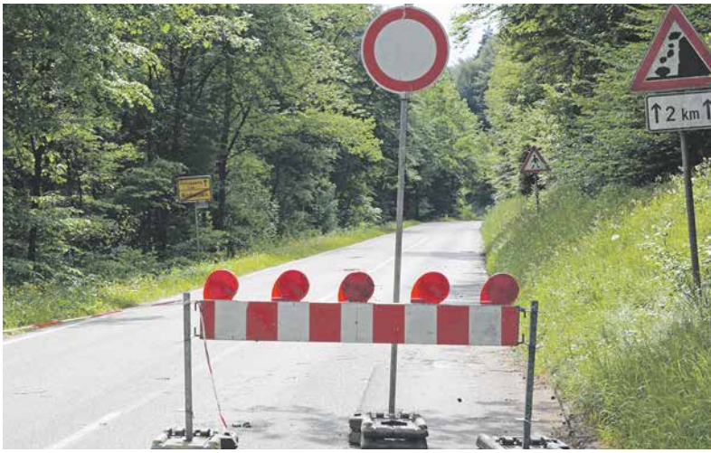
Bis Ende des Jahres ist die L 482 zwischen Pirmasens und Rodalben noch dicht. Nach dem Ausbau müsste das Schild "Vorsicht Steinschlag" überflüssig sein.
