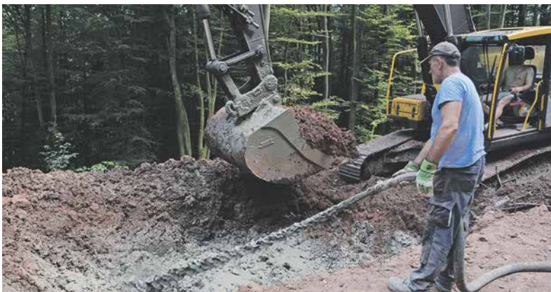
Bis zu zwei Meter dick ist der "Betonfelsbalken", der die Straße hunderte von Metern lang an der Hangseite tragen wird.
