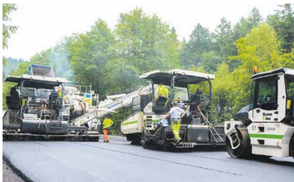
Der 4-Spur-Ausbau wird noch eine lange Zeit brauchen, solche Bilder von Straßenbaukolonnen wird es immer wieder geben.
