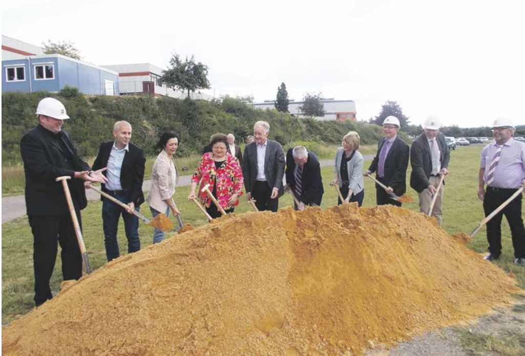
Der Landkreis Südwestpfalz investiert 17,5 Millionen Euro in den Neubau der Integrierten Gesamtschule Contwig. Beim Spatenstich für das neue Schulgebäude, von links: Bauleiter Martin Kerbeck, Schulleiter Thomas Höchst, die Bundestagsabgeordnete Angelika Glöckner (SPD) und Anita Schäfer (CDU), Architekt Hubertus Sander, Landrat Hans Jörg Duppré, die Kreisbeigeordnete Martina Wagner, Verbandsbürgermeister Jürgen Gundacker (Zweibrücken Land), Bauunternehmer Rolf Ehrhardt und Ortsbürgermeister Karlheinz Bärmann (Contwig).
