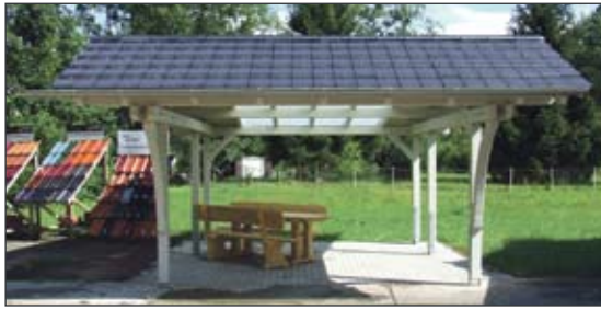
Individuell angefertigte Carports - Ein Beispiel aus dem umfangreichen Angebot der „HOLZBAUER GMBH“
