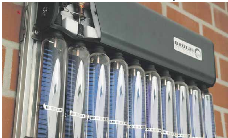
Vakuum-Röhren-Kollektoren sind ergiebiger als Flachkollektoren – allerdings auch teurer in der Anschaffung.
